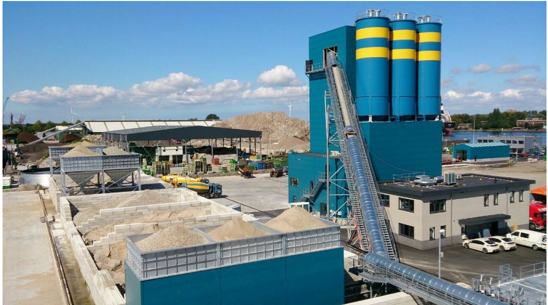
Figuur 7.1 Een betoncentrale.
