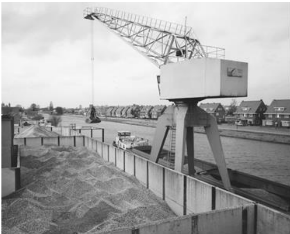
Figuur 7.4 Vullen van een bunker met toeslagmateriaal, Een ruime opslag is noodzakelijk.
